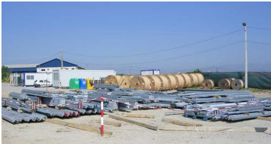
Fotografia 4.20 – Estaleiro de apoio à obra de construção de uma linha semelhante à agora em análise
