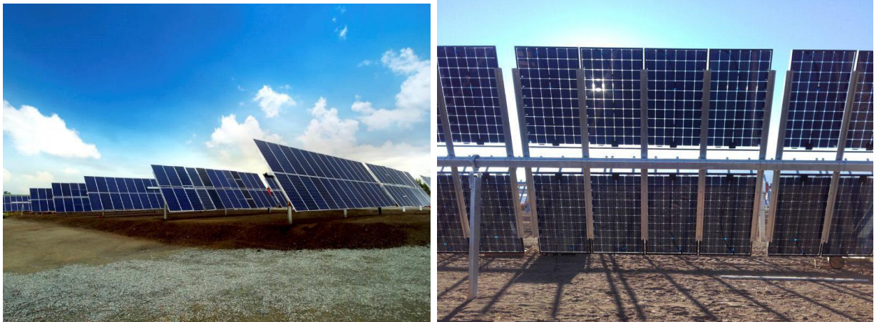
Fotografias 4.3 e 4.4 – Exemplo de Seguidores Solares - modelo Soltec SF7 Bi-facial
