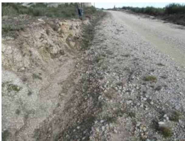
Fotografias 4.17 e 4.18 – Exemplo de valetas sem revestimento, observando-se à esquerda como é efetuado o encaminhamento do escoamento para a linha de água mais próxima
