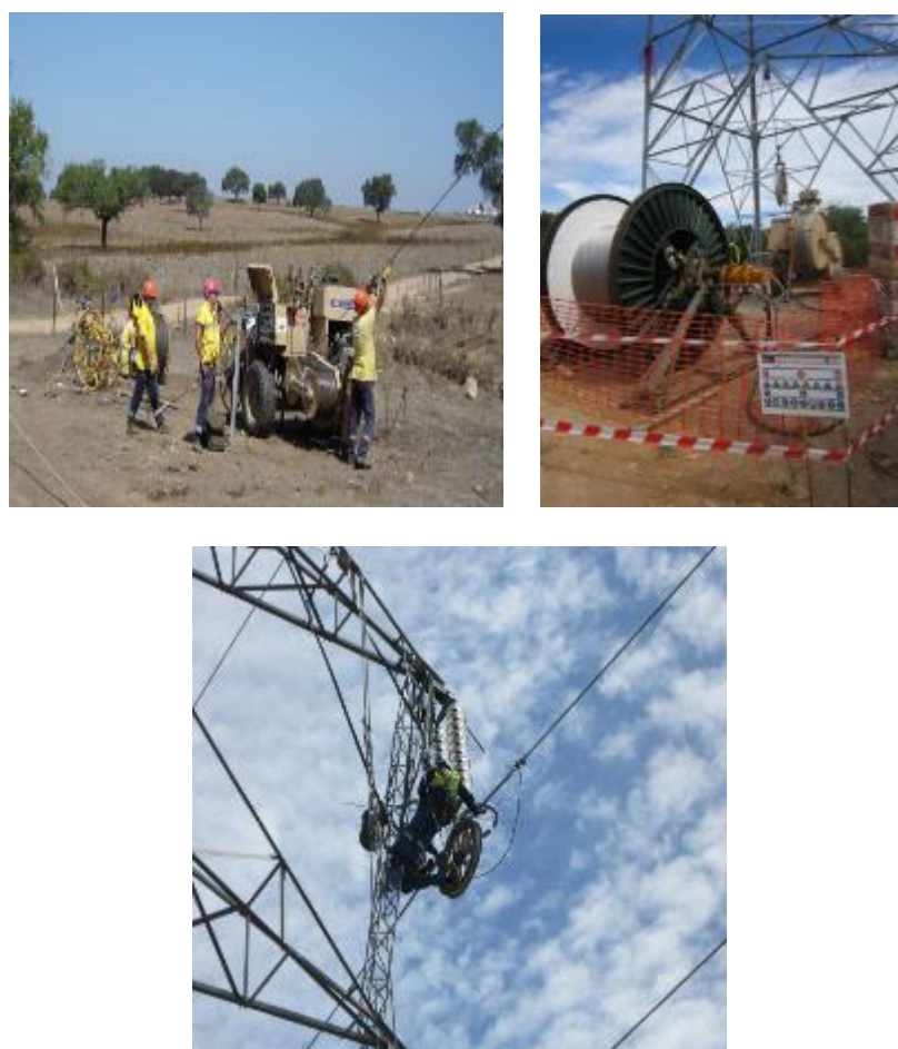
Fotografias 4.30, 4.31 e 4.32 Colocação dos cabos
