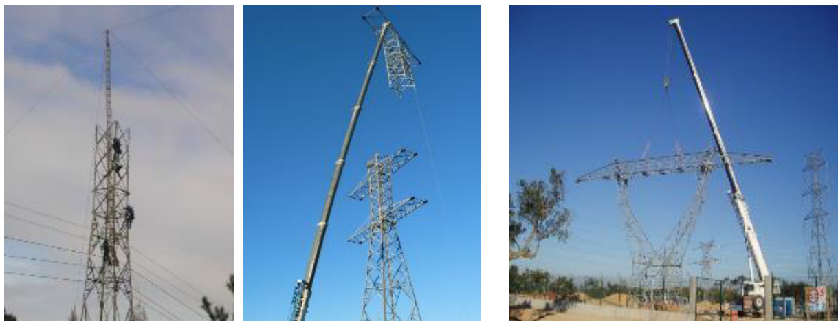
Fotografias 4.28 e 4.29 -Montagem da estrutura dos apoios
