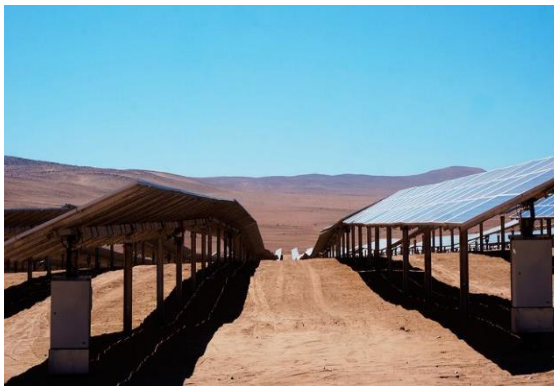
Fotografias 4.1 e 4.2 – Exemplo de módulos fotovoltaicos que acompanham a morfologia do terreno
