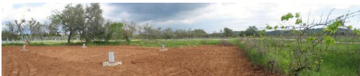
Fotografias 4.21, 4.22, 4.23 e 4.24- Execução das fundações dos apoios da linha
