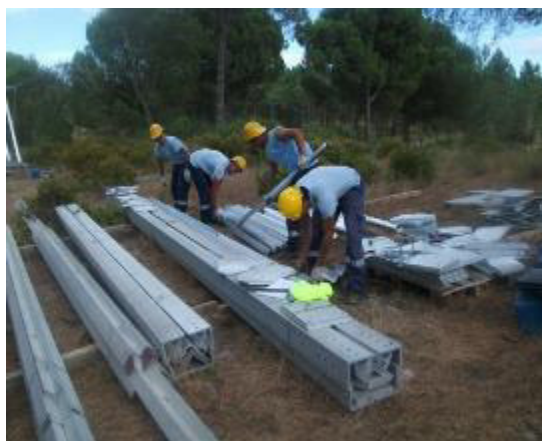
Fotografias 4.25 e 4.26 - Montagem da estrutura dos apoios
