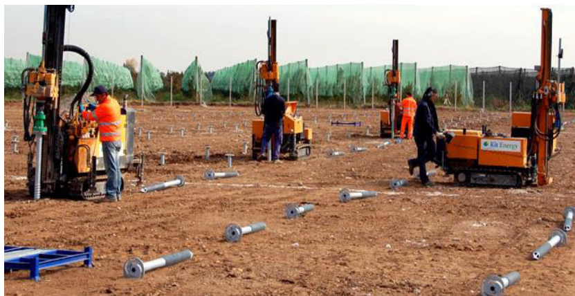
Fotografia 4.14 – Maquinaria utilizada para a perfuração
