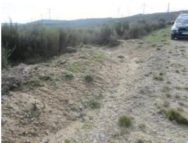
Fotografias 4.17 e 4.18 – Exemplo de valetas sem revestimento, observando-se à esquerda como é efetuado o encaminhamento do escoamento para a linha de água mais próxima
