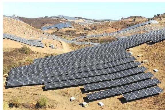
Fotografias 4.1 e 4.2 – Exemplo de módulos fotovoltaicos que acompanham a morfologia do terreno
