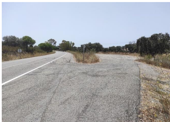
Fotografia 4.7 – Derivação da IC1 para acesso ao setor poente da Central Fotovoltaica (caminho que dá atualmente acesso ao conjunto edificado do Monte Novo à Rez)
